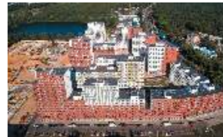
ЖК «Новокрасово», МО «Тройка РЭД»
